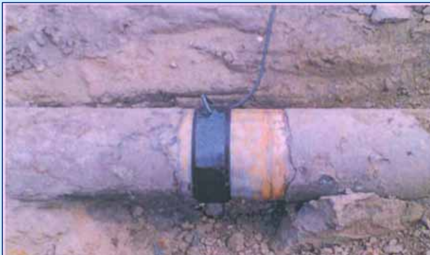
Posa a terra
